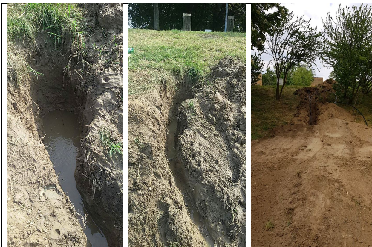
Слика 2. Оштећење насипа ископом; слева удесно: илегално постављена цев за довод воде до сплава је оштећена, што је расквасило и угрозило труп насипа – неопходна је санација на одређеној деоници; ископ ради постављања водоводне цеви и импровизовано затрпавање ископа – место потенцијалног пробоја насипа
