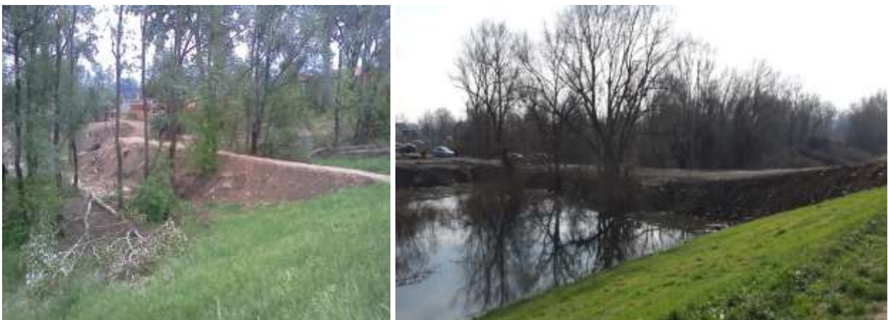
Слика 5. Нелегално саграђени 'приватни' попречни насипи у кориту за велику воду узводно од Новог Београда, који ометају евакуацију великих вода, додатно угрожавајући безбедност насипа
