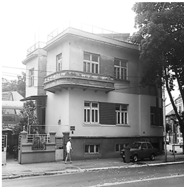
Slika 4: Zgrada u ulici Prvovenčanog kralja, izvor: autori; Jovanović, Jovanović
