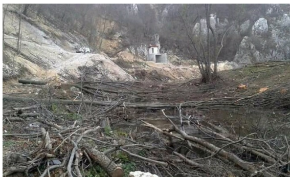
Slika 1. Gradilište MHE Krepoljin na Mlavi u zoni koje je Prostornim planom Srbije rezervisano kao izvorište
