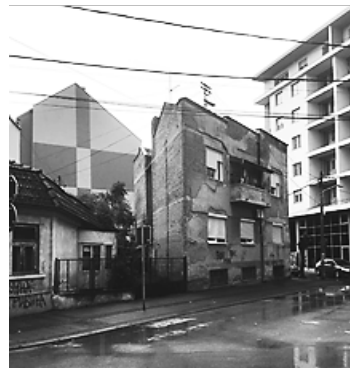
Slika 3, : Zgrada u ulici Zelengorskoj, : autori Jovanović, Jovanović
