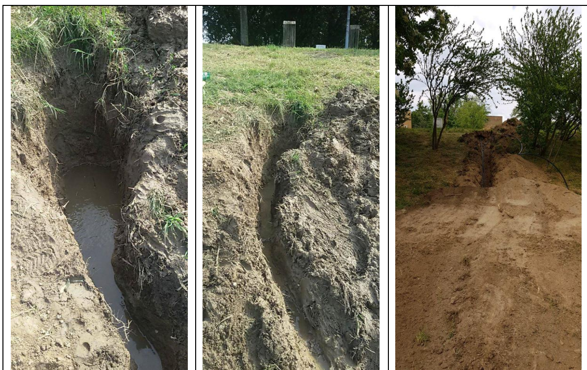
Слика 2. Оштећење насипа ископом који су неlegalно извршили неодговорни појединци, за своје приватне потребе. Прве две слике са лева у десно: иlegalно постављена цев за довод воде до сплава је оштећена, па је дуготрајно процуривање у тело насипа расквасило и угрозило конструкцију насипа на ширем потезу, тако да је неопходна санација те деонице. Слика крајње десно: ископ рова ради постављања водоводне цеви је импровизовано затрпан, тако да је то место потенцијалног пробоја насипа убрзо након формирања успора у Сави када достигне тај ниво.
